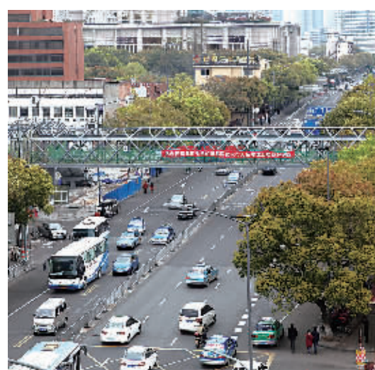
正在建造中的妇儿医院天桥。(胡建华 摄)
